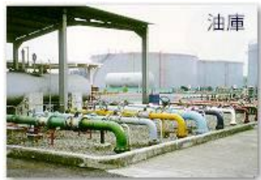
圖 6.3-2 存放油料之油庫
