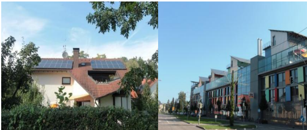
圖 9.4-4 家庭及商業區屋頂加裝太陽能面板
